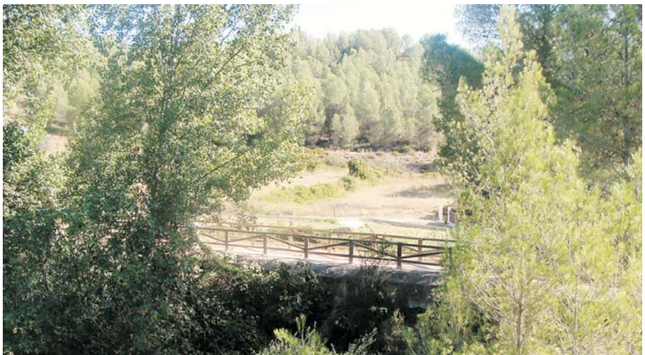
Panorámica del puente-acueducto de inicio de la ruta
